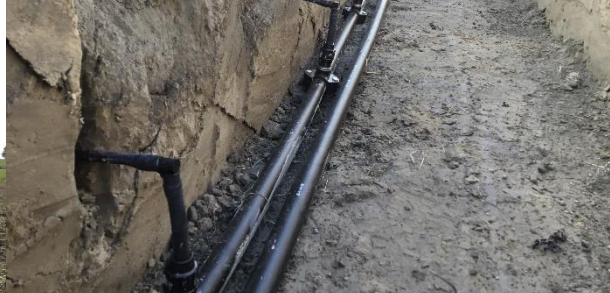
Figuur 2: Bovenste rij foto's: meet- en regelunit nabij het proefveld, voor juiste water giften aan het proefveld (zoet en zoutwater in de verschillende secties). Middelste rij foto's: plaatsen druppelslangen in het nkg-deel van het veld (oktober 2019). Onderste rij foto's: plaatsen druppelslangen in het kerende deel van het veld (september 2020).
